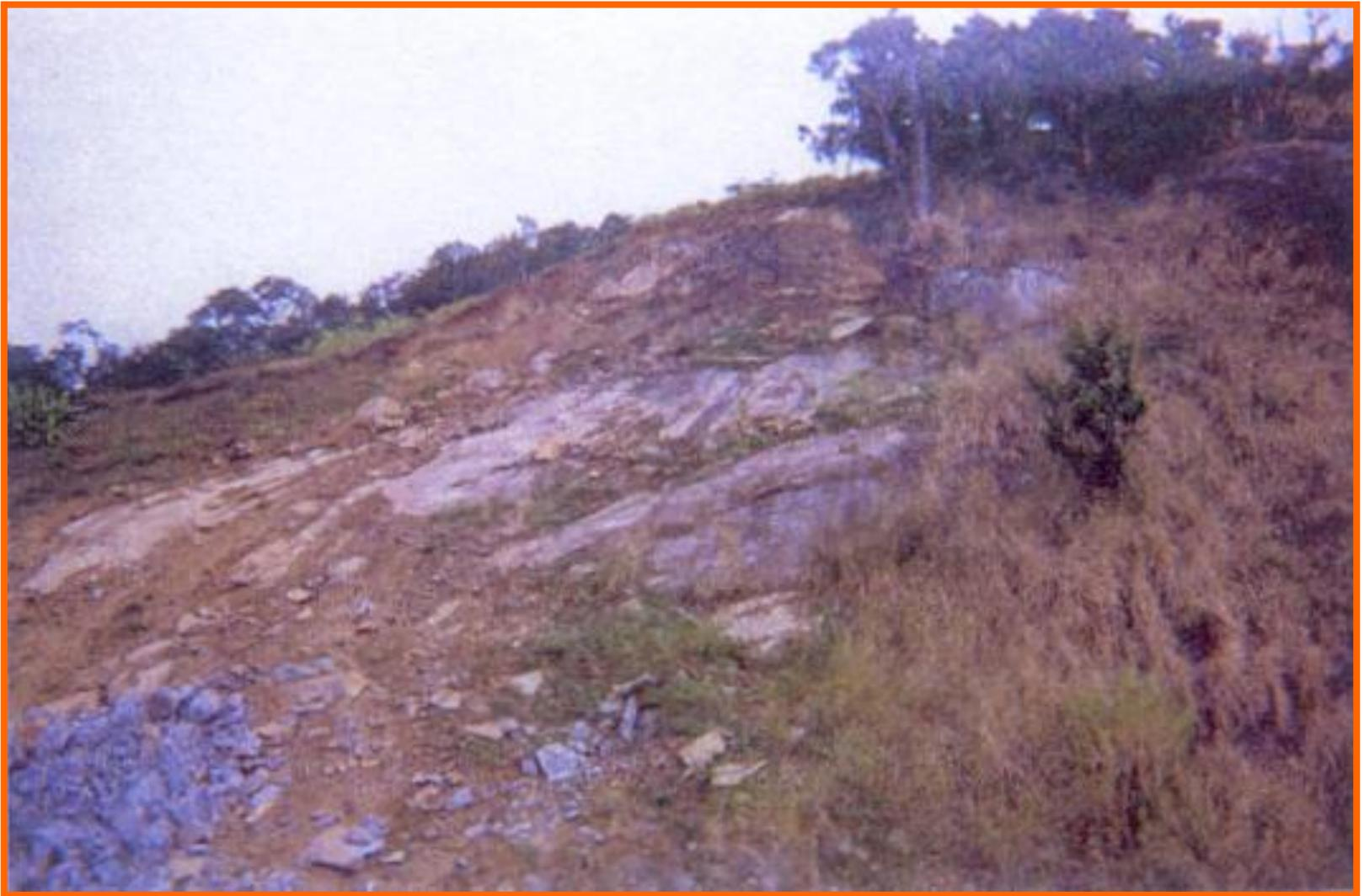
**Deslizamento de rocha ao longo de juntas de alívio devido a corte do talude.**
