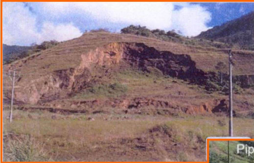
**Deslizamento em Solo Residual
